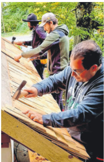
Die Bauarbeiten konnten kürzlich abgeschlossen werden.
